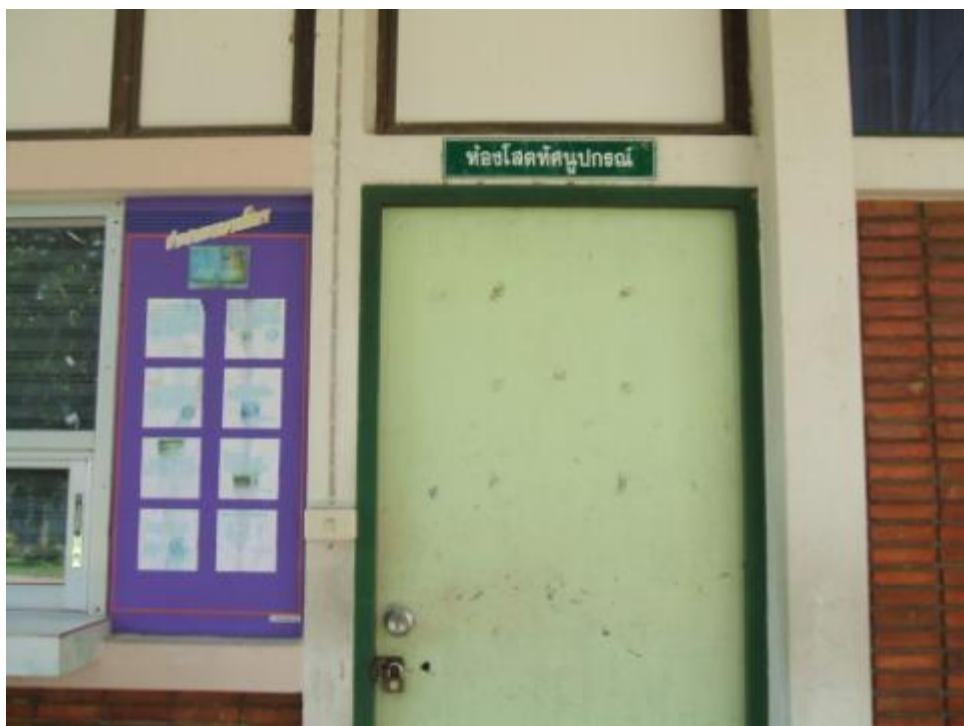
10. อาคารโสตทัศนูปกรณ์ (306.24 ตรม.)
